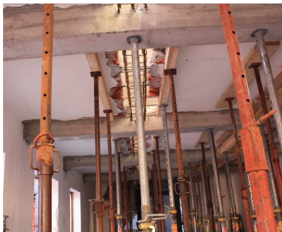
Opere di rinforzo solaio del basso corpo
