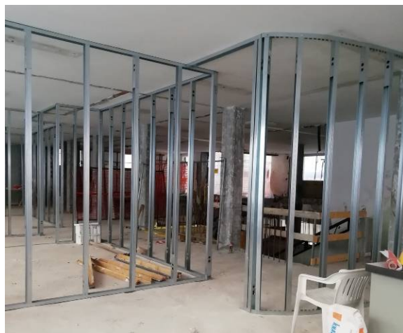
Predisposizione strutture per pareti divisorie
